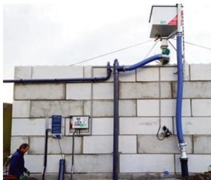
Der Separator wurde auf diesem Kuhbetrieb auf einer Betonwand befestigt, um die Feststoffe darunter zu sammeln.
